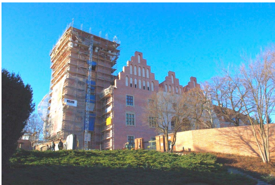
Il. 5. Nowy zamek na Wzgórzu Przemysła tuż przed ukończeniem budowy, 2012, fot. Tomasz Ratajczak
