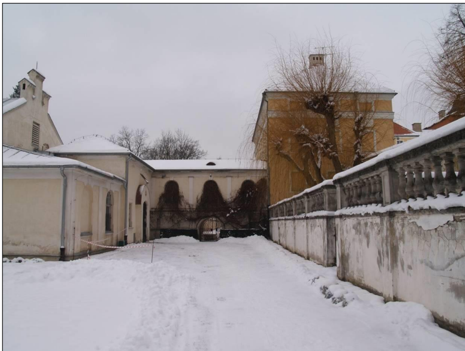
Il. 68. Rogalin – łącznik między galerią a skrzydłem południowym pałacu, stan obecny
