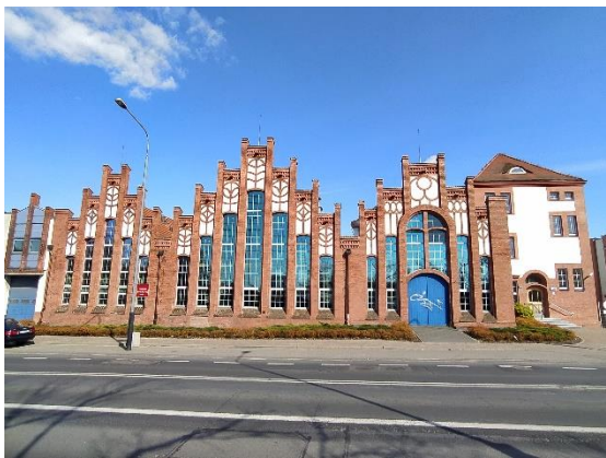
Fot. 12. Zabytkowa przepompownia ścieków Autor: D. Abramowicz
